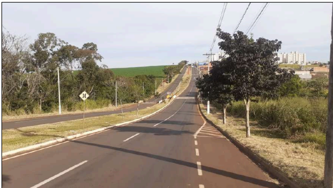
Vista do local – Sentido Norte / Sul
