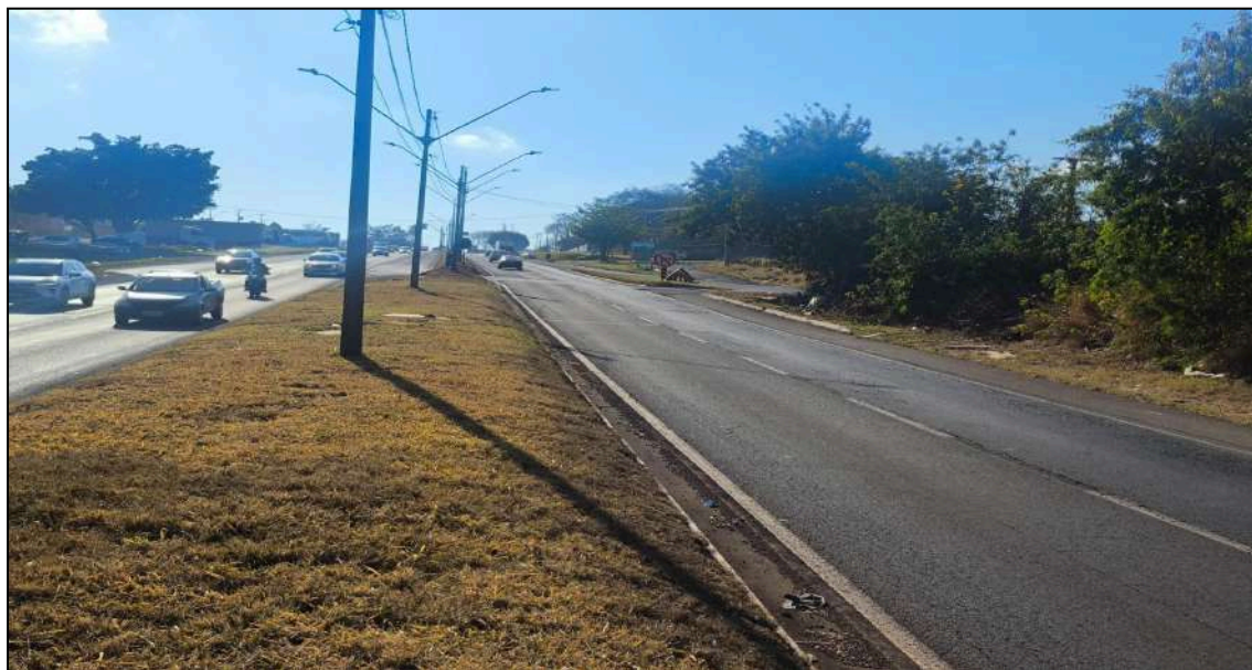
Vista do local – Sentido Oeste / Leste
