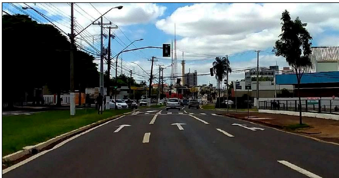
Vista do local – Sentido Oeste / Leste
