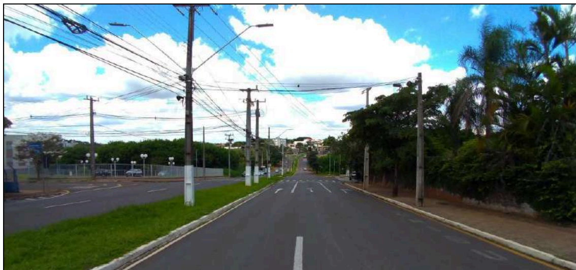
Vista do local – Sentido Norte / Sul
