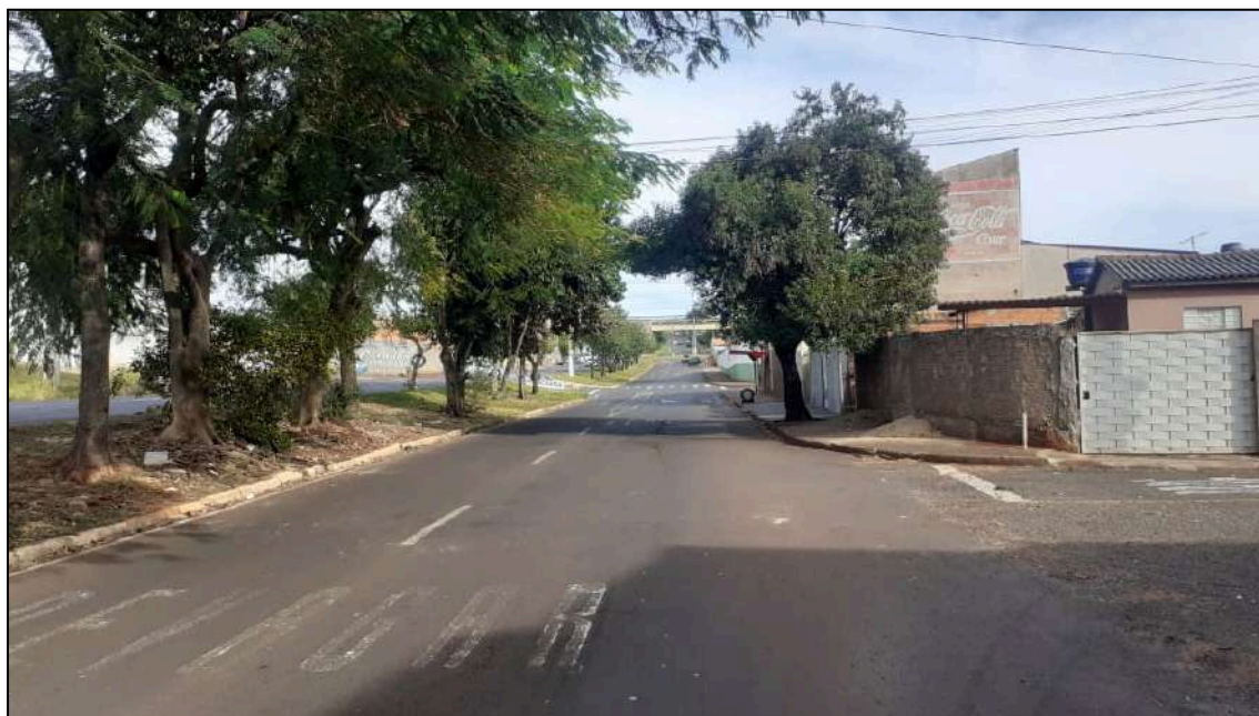
Vista do local – Sentido Norte / Sul
