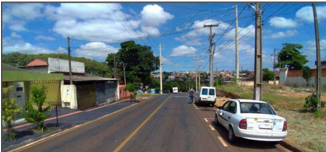
Vista do local – Sentido Nordeste / Sudoeste
