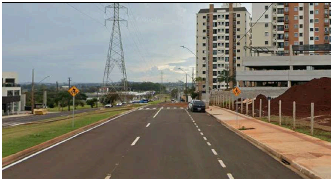
Vista do local – Sentido Nordeste / Sudoeste
