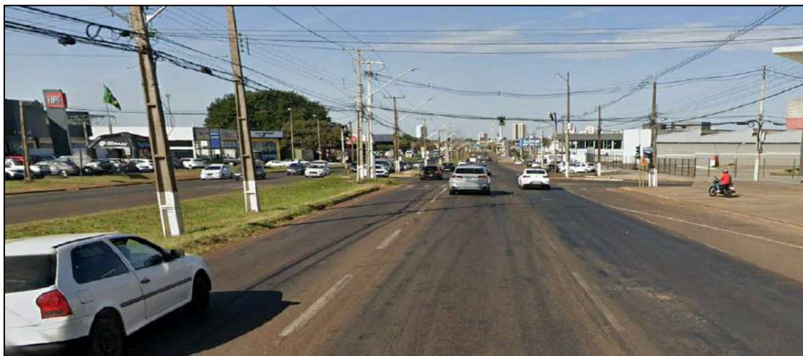
Vista do local – Sentido Oeste / Leste
