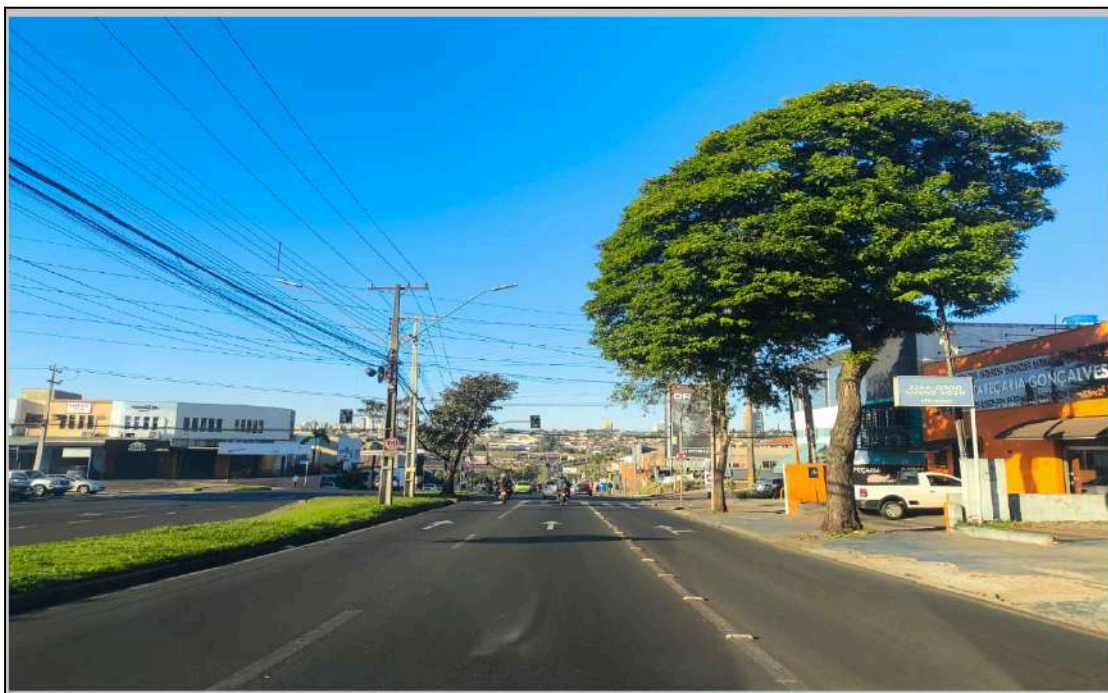
Vista do local – Sentido Norte / Sul
