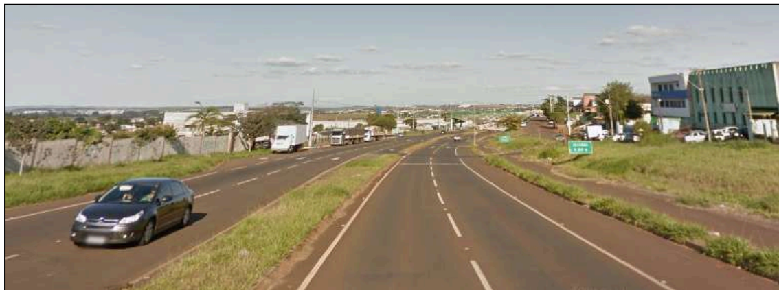
Vista do local – Sentido Norte / Sul
