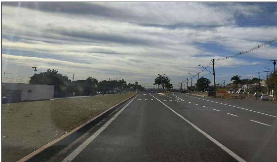
Vista do local – Sentido Oeste / Leste
