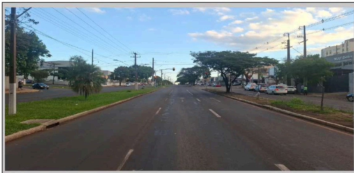
Vista do local – Sentido Norte / Sul
