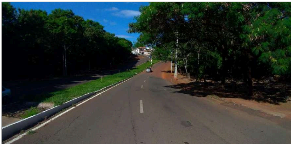
Vista do local – Sentido Norte / Sul
