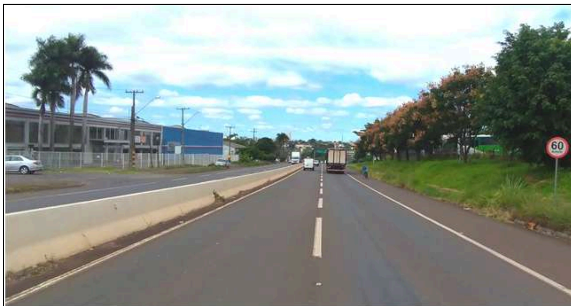
Vista do local – Sentido Norte / Sul
